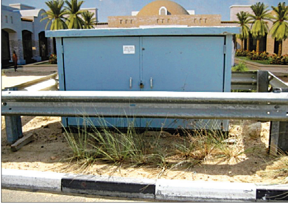
5.4.1 علبه وصل عمودية محمية بواسطة حاجز فولاذي بجانب الطريق
