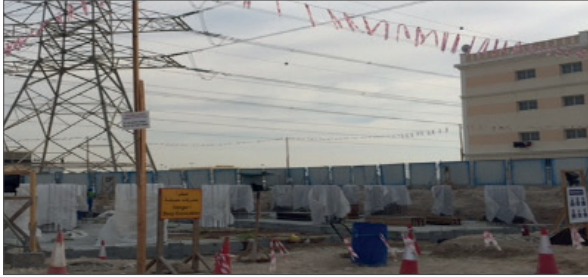
حماية أساسات الأبراج باستخدام الحواجز الخرسانية
