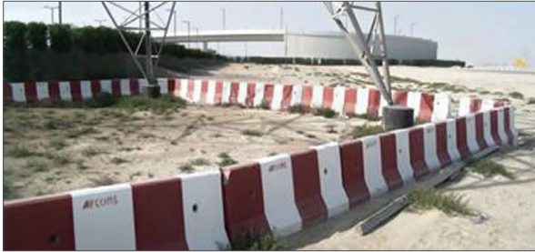
حماية أساسات الأبراج باستخدام الحواجز الخرسانية
