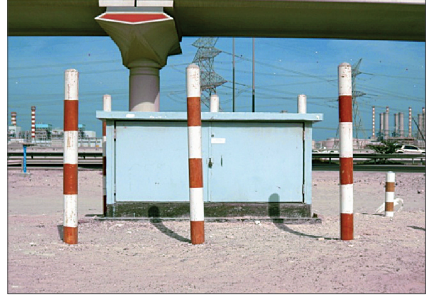
4.4.1 علبه وصل عمودية محمية بواسطة أعمدة من الفولاذ
